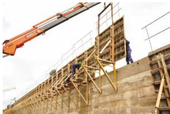
Detalhe do Içamento
